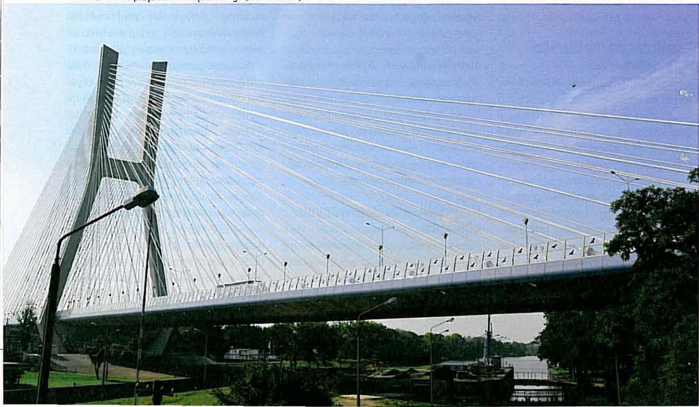
Fot. 4 | Główne przęsło mostu Rędzińskiego (fot. R. Sienko)
