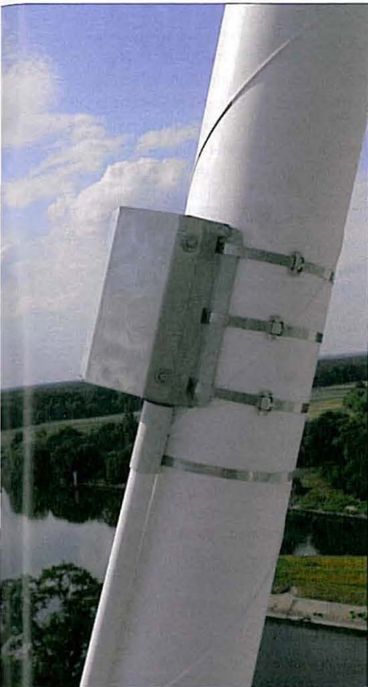
Fot. 5 | Widok z pylonu przęsła nurtowego mostu Rędzińskiego w czasie budowy oraz obudowa czujnika drgań na jednej z want (fot. R. Sienko)
